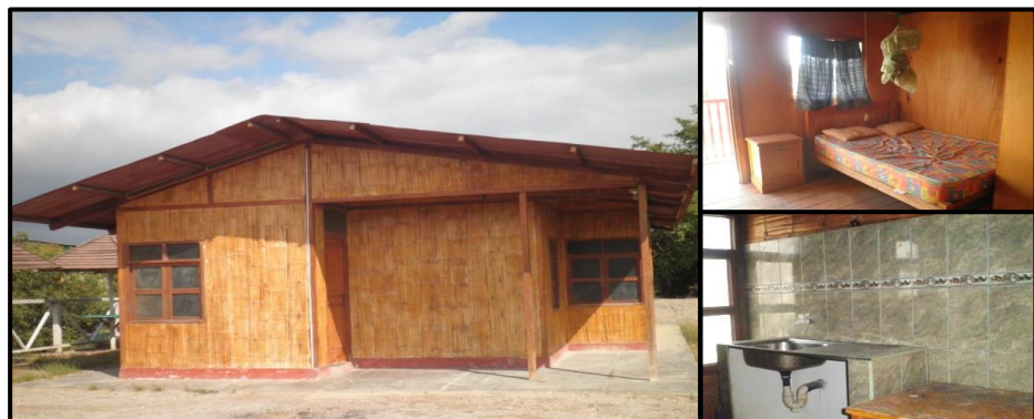
Imagen 5: Infraestructura para alojamiento en Puerto 25.
