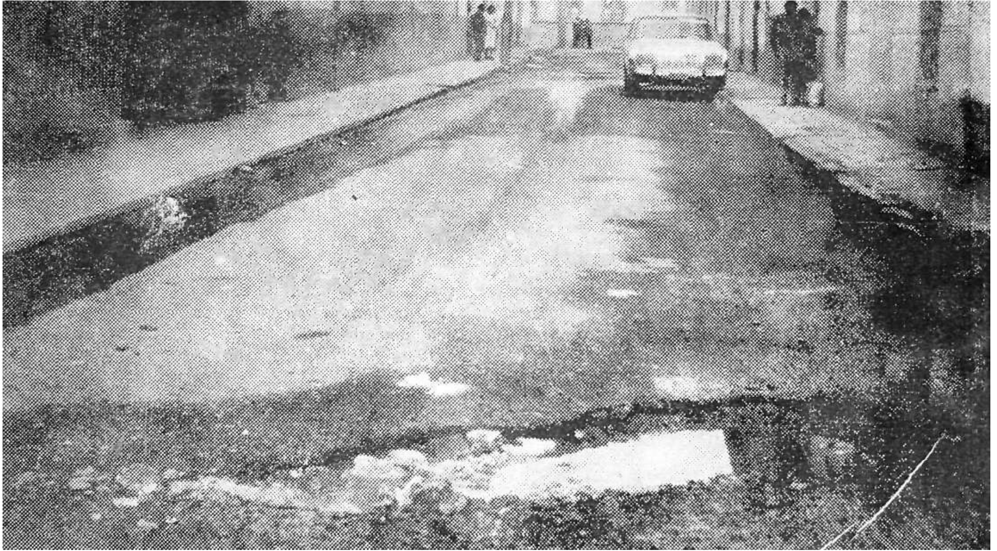
Numerosas calles de Huancayo han sido afectados por las continuas lluvias que van cayendo en estos días, en diversos sectores se han formado grandes huecos, charcos de agua .
