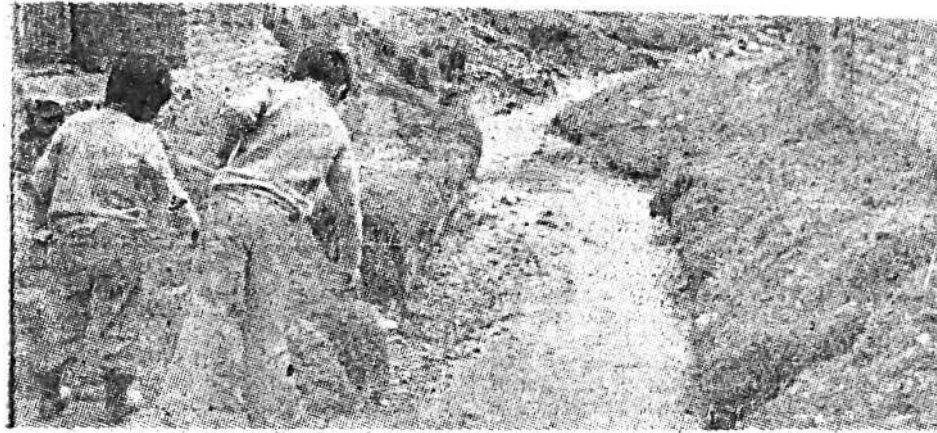
El río Chilca constituyó un peligro para las familias que viven en sus riberas. Cada año que se desborda ocasiona daños materiales.
