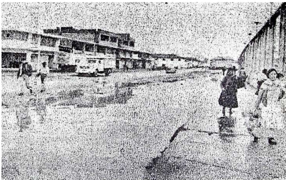
Las Primeras lluvias que cayeron sobre nuestra ciudad inundaron las principales arterías. La población —como todos los años—tendrá que soportar enormes dificultades para transitar por ellas.
