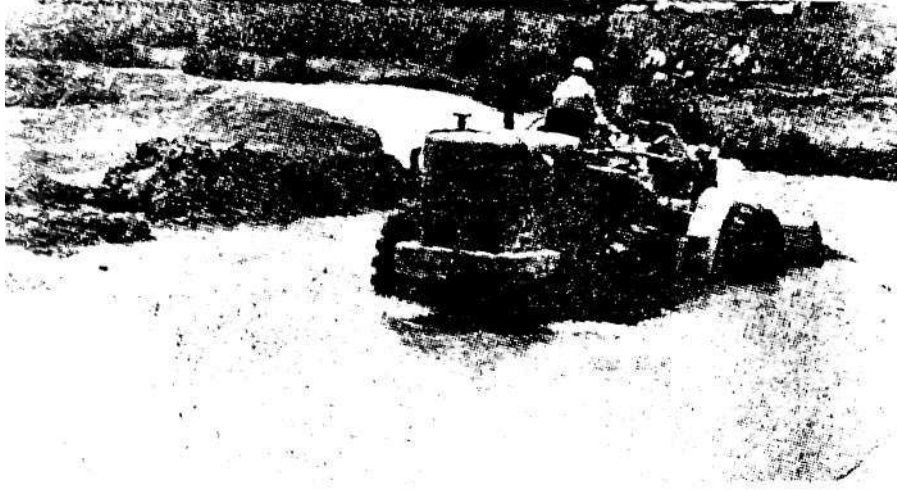
MARAVILCA, (CORREO).— Maquinaria de la Región Agraria XVI tiene a su cargo la limpieza del río, a fin de evitar otras inundaciones.
