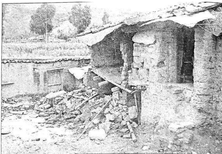
CASA colapsada a consecuencia de las lluvias.
