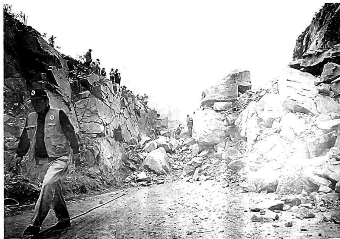
DESTROZADA. Inmensas rocas taparon la plataforma de la Carretera Central, impidiendo el tránsito
